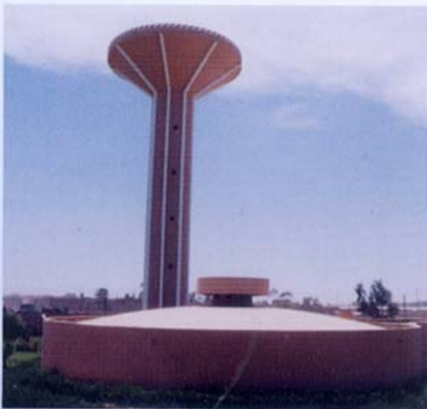
Réservoir d'eau potable
