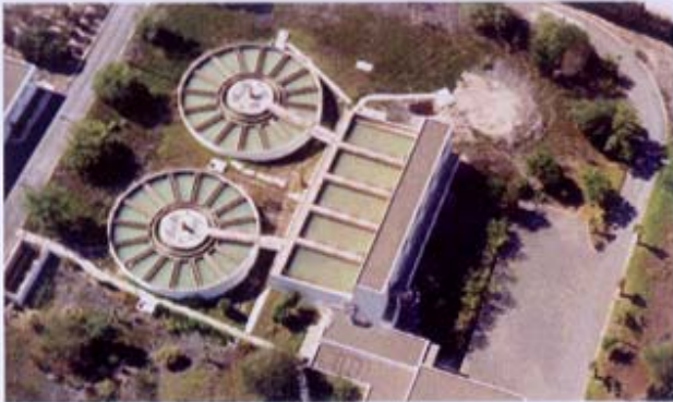
Station de traitement de Nador
