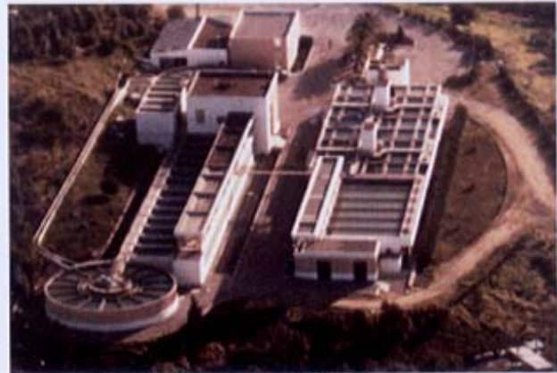
Station de traitement de M'Harhar
