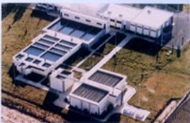
Station de traitement d'Al Hoceima
