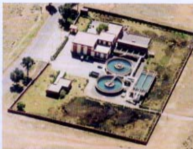
Station de traitement de Khenifra
