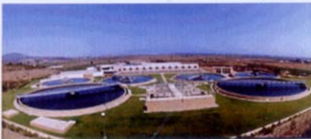
Station de traitement de Smir
