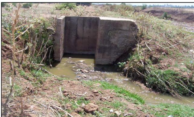
**Photo N°10:** Nouveau point de rejet du CPA, profond par rapport au niveau du sol (faible pente)
