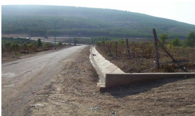
**Photo N°7:** Evacuation des eaux pluviales Nahda I vers oued Arid
