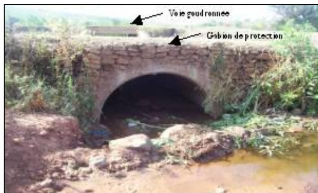
**Photo N°8:** tronçon exposé au crues d'oued arid, Route R401 (Ouest Nahda) ,CPA tronçon 42-43 Traversée oued Arid (42-43)
