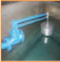
السكر العائم (Robinet flotteur) نجدّه في الخزان وذلك من أجل إقفال الماء عندما يمتلأ الخزان
