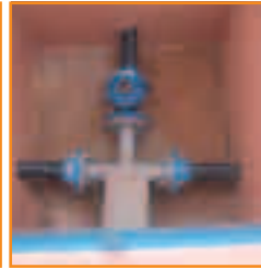
المنفس (VENTOUSE) يوضع بالأماكن العليا لإدخال الهواء لحظة إفراغ القناة من الماء وإخراج الهواء المتراكم داخل القناة أثناء ملئ القناة و بالتالي حماية القناة
