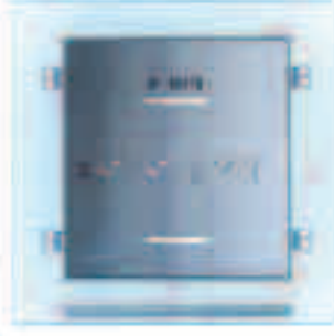
وضع باب صندوق الربط المصنوع من الحديد الذي يحمل رقم عقدة الاشتراك
